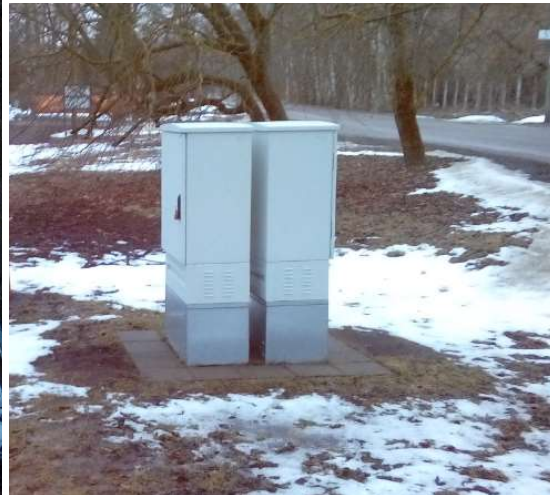
Pilt 1. Vahejaotuskapp (vasak) ja peajaotuskapp (parem)
