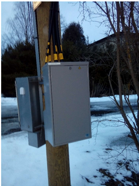
Pilt 1. Vahejaotuskapp (vasak) ja peajaotuskapp (parem)
